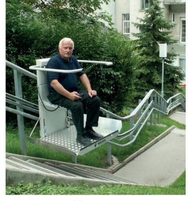
Der **batterielose Antrieb** erlaubt auch bei Außenanlagen sehr lange Fahrstrecken
